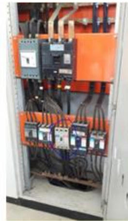
Figura 7: Disjuntor do Auditório no QGBT
