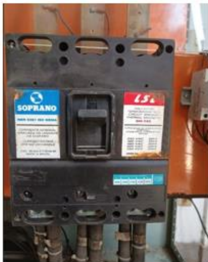
Figura 1: Disjuntor do TR-01
