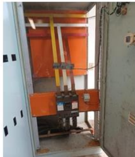
Figura 2: Disjuntor do TR-01 no QGBT
