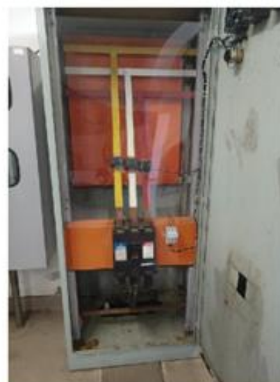
Figura 5: Disjuntor do TR-02 no QGBT
