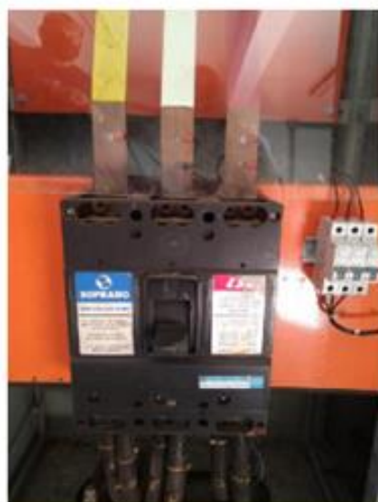
Figura 4: Disjuntor do TR-02
